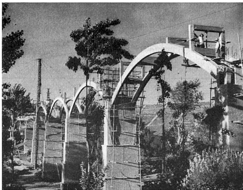
Fig. 4. Ossature préfabriquée et poteau métallique de montage de l'aqueduc de Cubillas.
