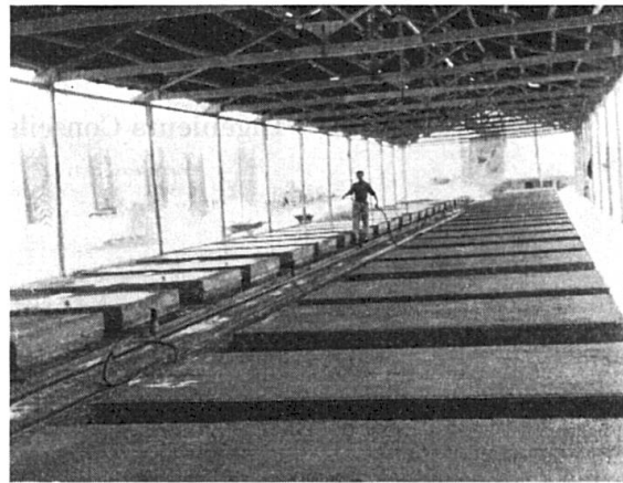
Fig. 2. Aire de fabrication des dalles.
