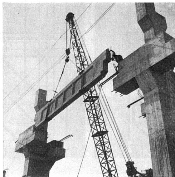
Fig. 5. Assemblage de poutres préfabriquées avec des consoles coulées sur place.
