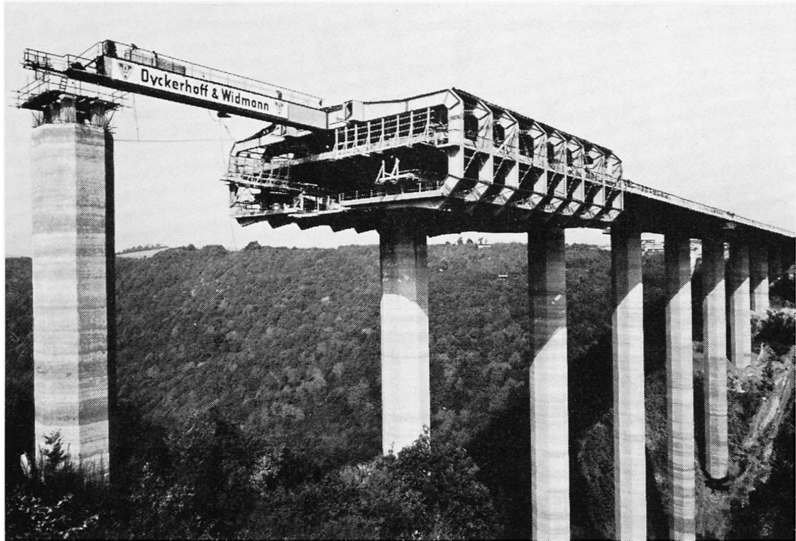
Fig. 27. Vorschubgerüst für den Überbau der Elztalbrücke (siehe Fig. 26).
