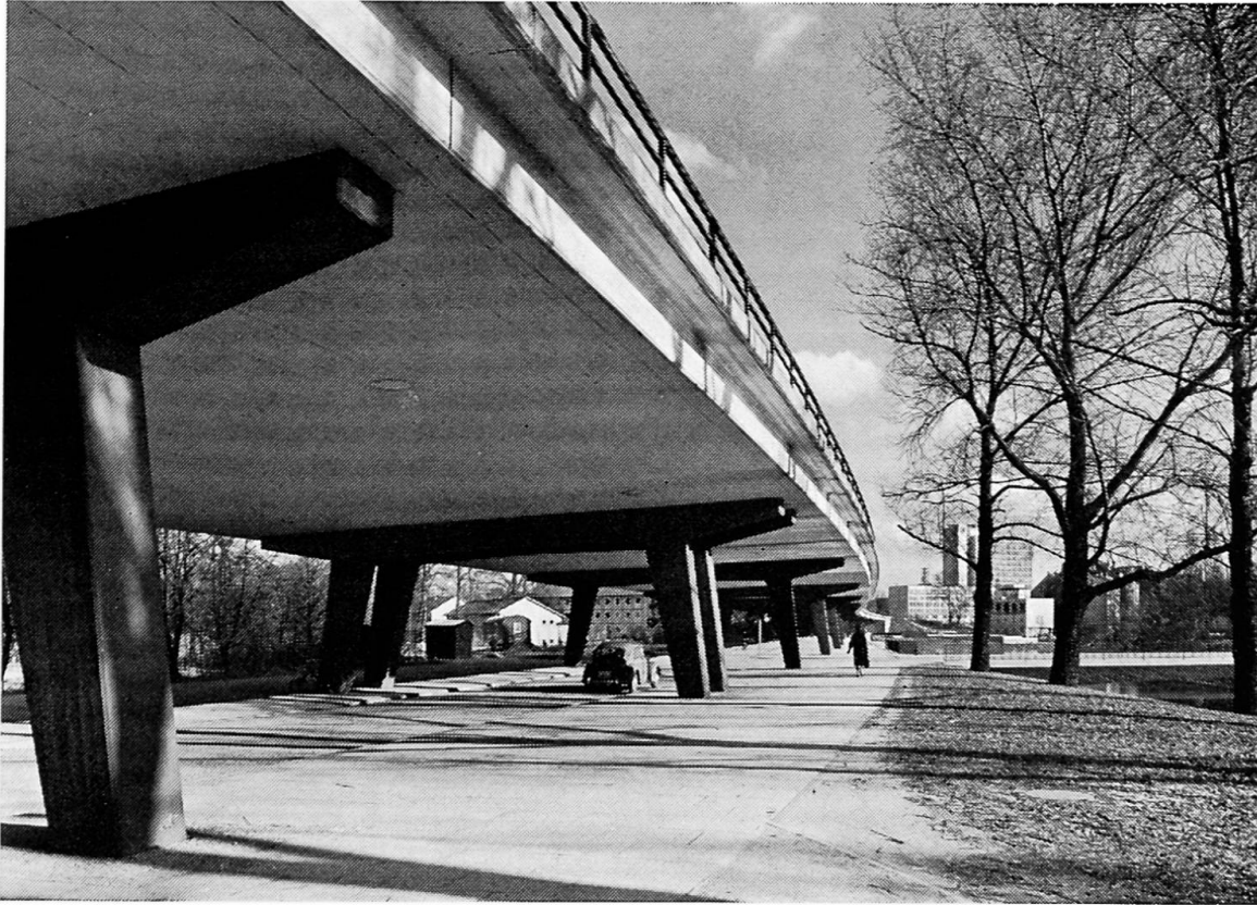
Fig. 18. Hochstraßenbrücke Fischerstraße in Hannover, Deutschland.
