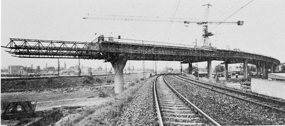
Bild 13 Stadtkerntangente Mainz Vorschubrüstung kreuzt eine Eisenbahnlinie
