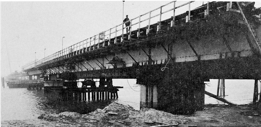
Bild 12 Eiderbrücke Tönning Vorschubrüstung mit Zwischenabstützung
