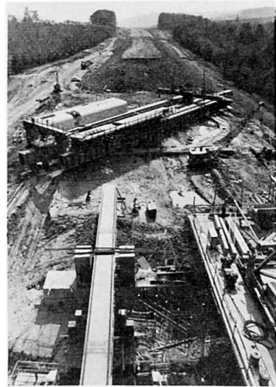
Bild 5 Drehen einer Vorschubrüstung hinter einem Widerlager
