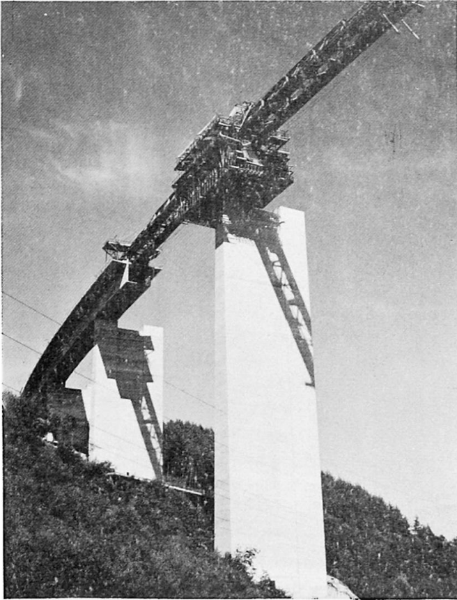
Bild 16 Siegtalbrücke Eiserfeld - Vorschubrüstung für Spannweiten über 100 m
