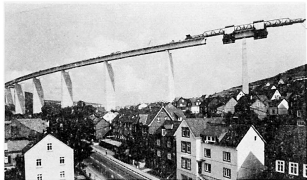
Bild 18 Siegtalbrücke Eiserfeld Bauzustand aus der Talsicht
