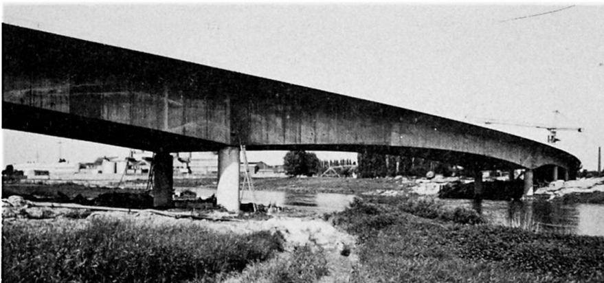
Bild 11 Weserbrücke Minden Zweistegiger Plattenbalken mit 100 m Spannweite
