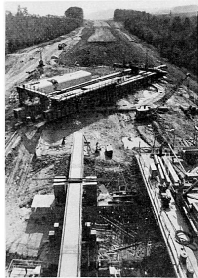
Bild 5 Drehen einer Vorschubrüstung hinter einem Widerlager
