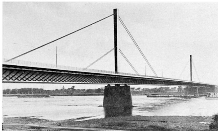
Bild 5: Rheinbrücke Leverkusen; einwandige Schrägseilbrücke
