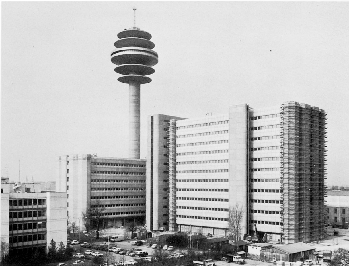
DER RICHTFUNKTURM DES FERNMELDEZENTRUMS WIEN-ARSENAL
