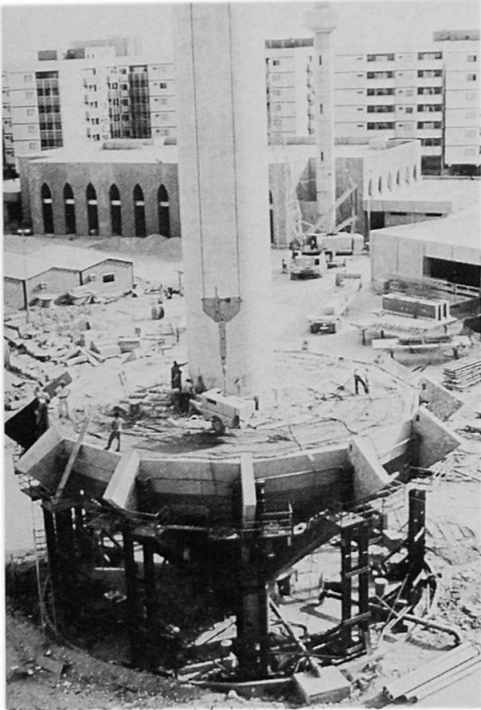
Bild 8 Der Hochbehälter nach Abschluß der Betonierarbeiten
