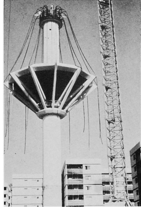
Bild 9 Der Hochbehälter wird gehoben
