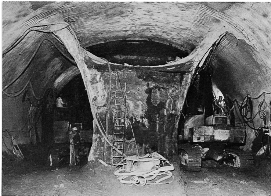
Bild 11: Mehrgleisiger Querschnitt
