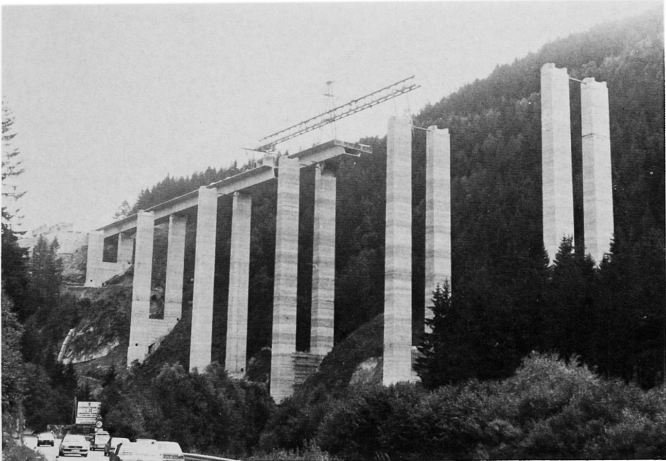
Bild 3 Montage der Brückenfertigteile (Segmente)
