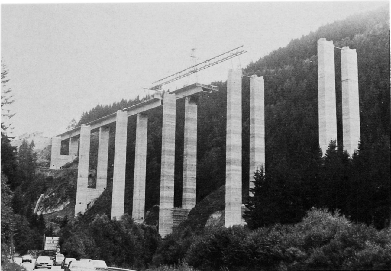
Bild 3 Montage der Brückenfertigteile (Segmente)
