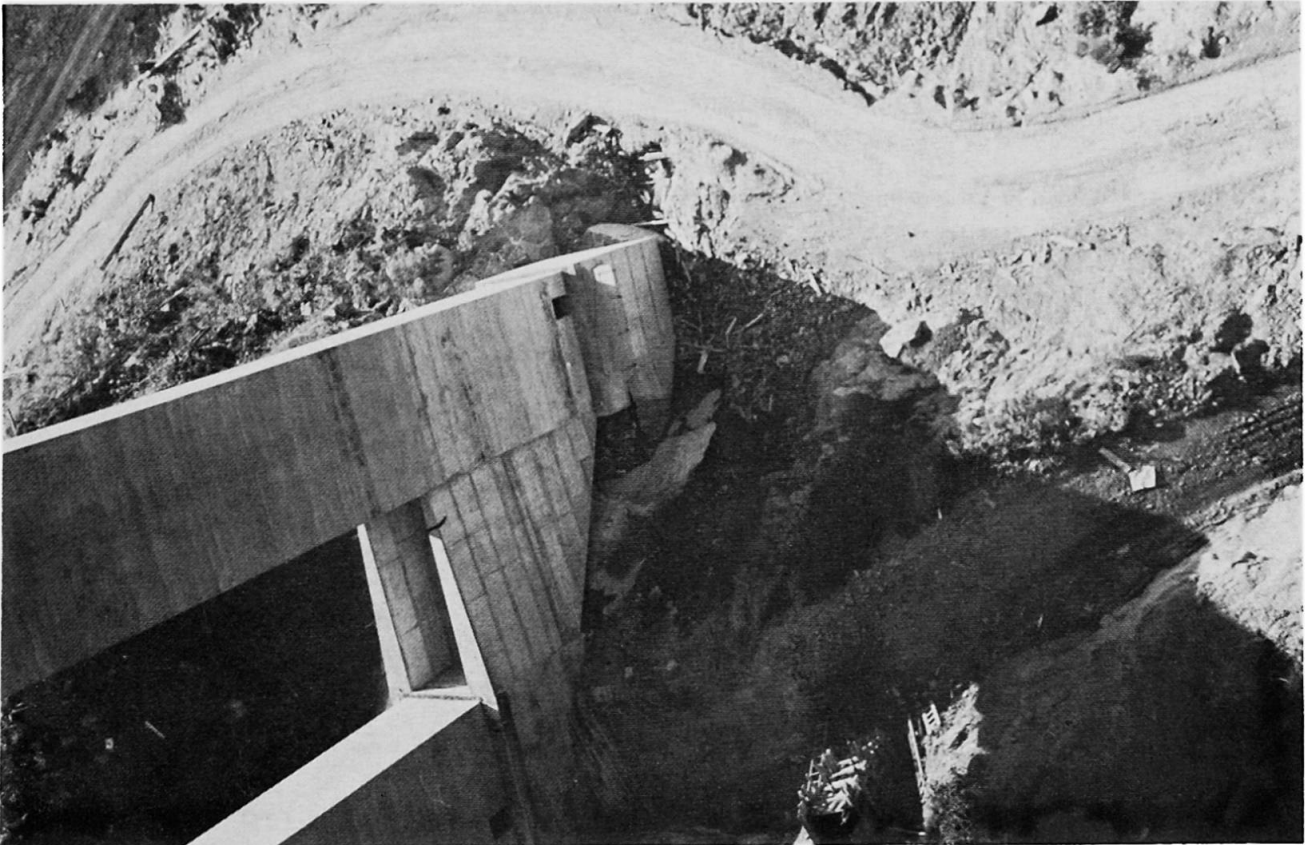
Bild 2 Pfeilerfuß mit Zufahrtsstraßen (von der Brücke aus nach unten gesehen)
