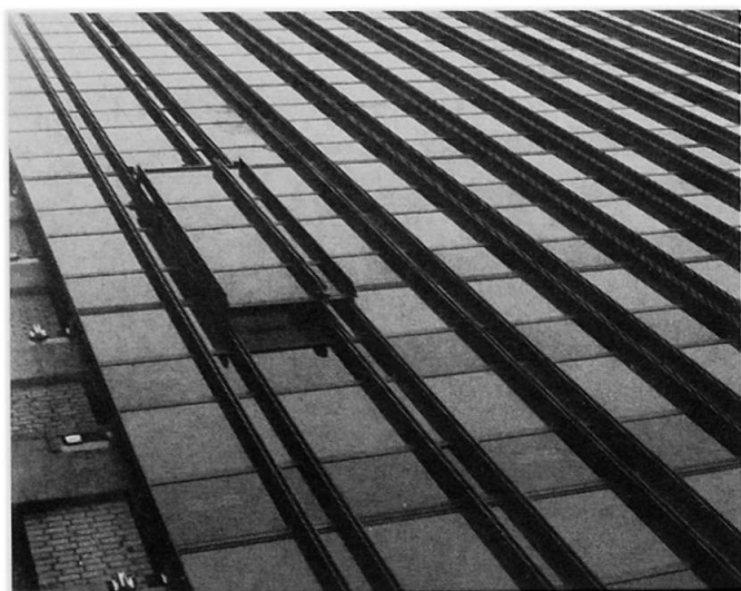
Bild 2 Aufziehen eines zwei Geschoss hohen Fassadenelements
