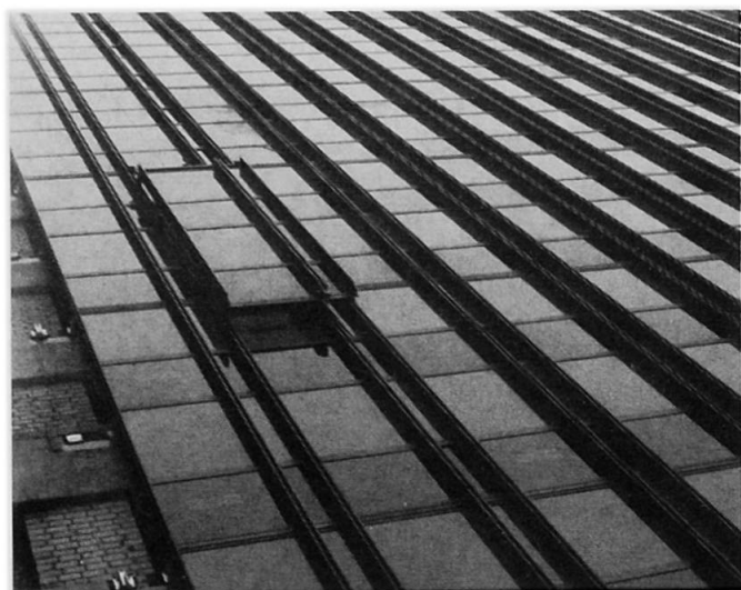
Bild 2 Aufziehen eines zwei Geschoss hohen Fassadenelements
