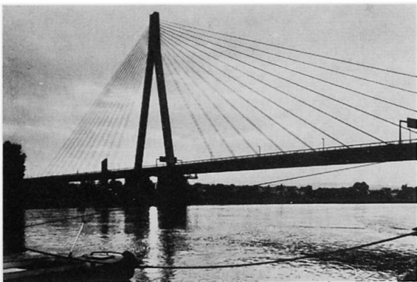
Pont de Raiffeisen
