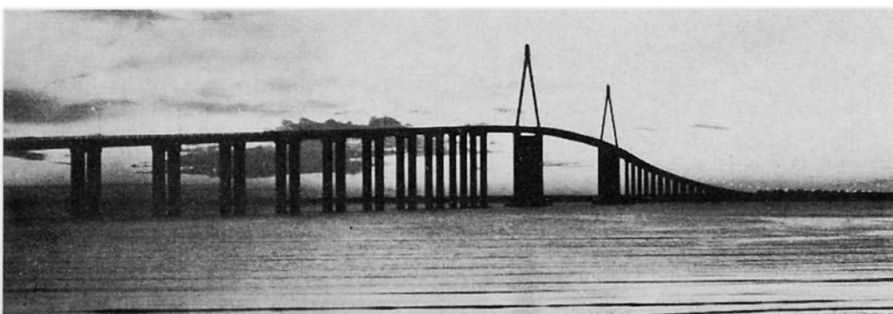
Pont de Saint-Nazaire
