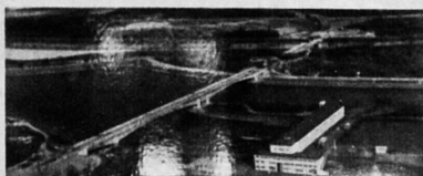
VUE AERIEENNE D'ENSEMBLE
