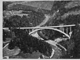
LINGENAUER BOGENBRÜCKE (TALERNAUTOBahn)
