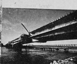
BRUNNENBRÜCKE LAUTERBACH (TALERNAUTOBahn)
