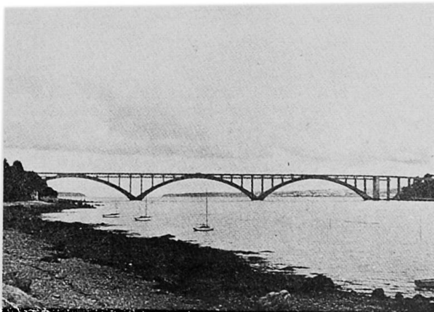
Fig. 17 - Pont de PLOUGASTEL (portée 186 m)
