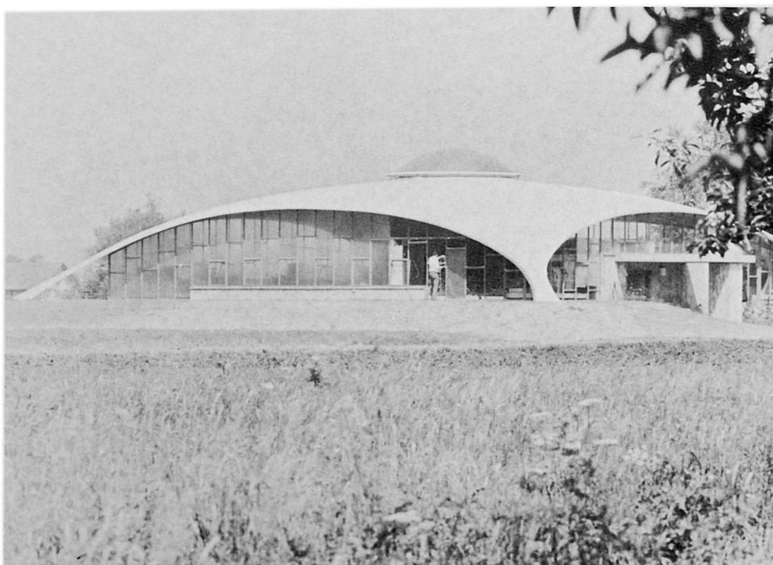
Ausstellungshalle Kilcher in Rechterswil
