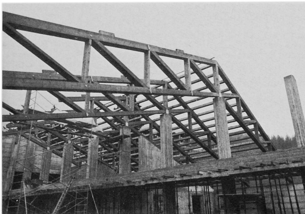
Bild 3 Fachwerkbinder für Hallenbad (13 und 15 m)
