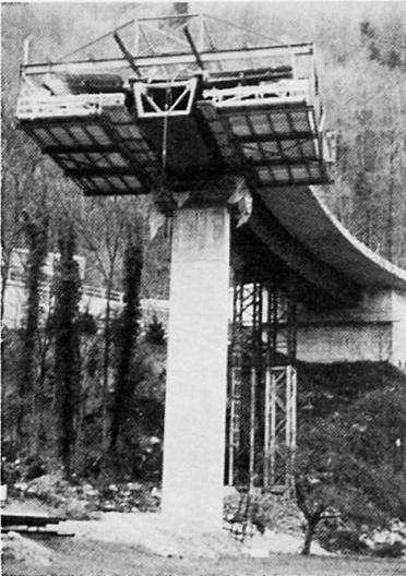
Betonieren der Fahrbahnplatte zwischen WL Nord und P 9
