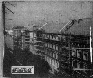
Reko-Taktstraße mit industriellem Gerüstbau Teamarbeit VEB KBR und TH Leipzig Foto L.B. Kopp
