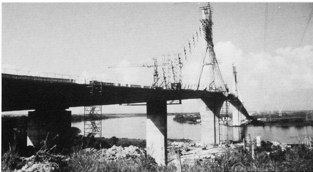
Figure 13 : Vue générale du pont.
