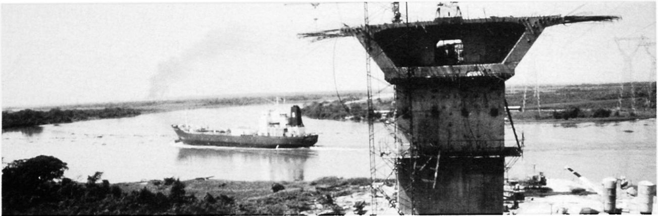
Figure 1 : Vue générale du site depuis la pile 2 vers Minatitlan
