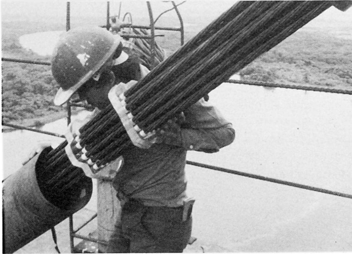
Figure 9 : Enfilage de torons.
