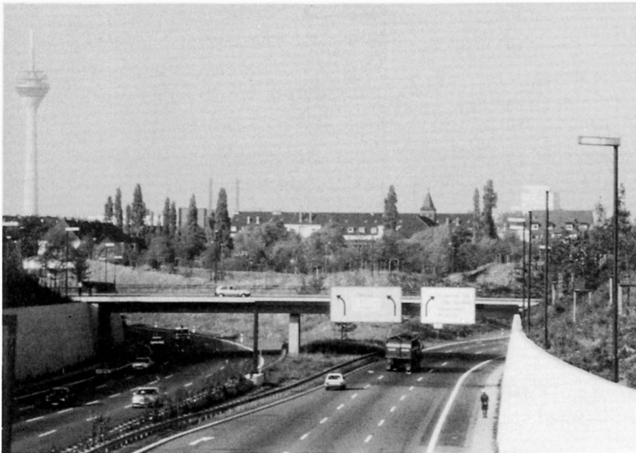
Bild 1: Brücke Ulenbergstraße Düsseldorf
