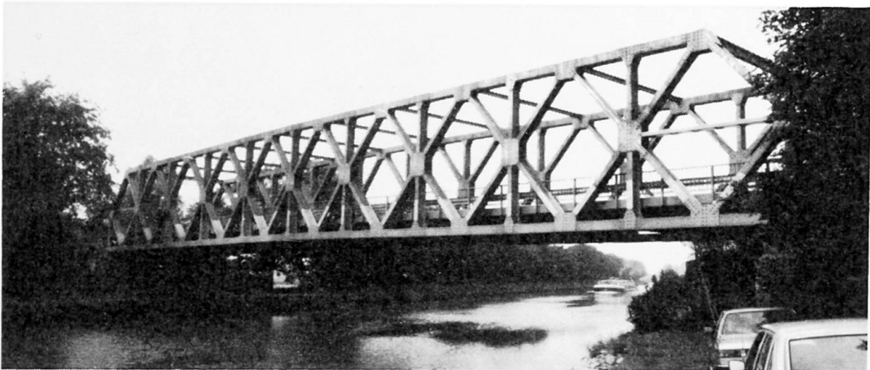
Fig. 1 Untersuchte genietete Fachwerk-Straßenbrücke
