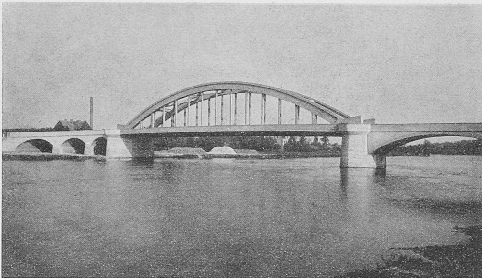
Fig. 5. Brücke über die Saale bei Alsleben — Pont sur la Saale à Alsleben — Saale Bridge near Alsleben.
