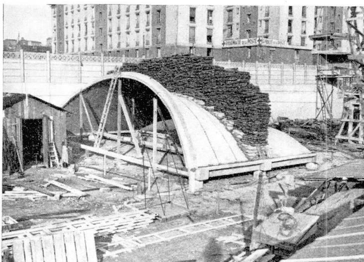
Fig. 5. Vue de la voûte au cours du deuxième essai. — Ansicht der Schale im Verlauf des zweiten Versuches. — View of shell during 2nd test.
