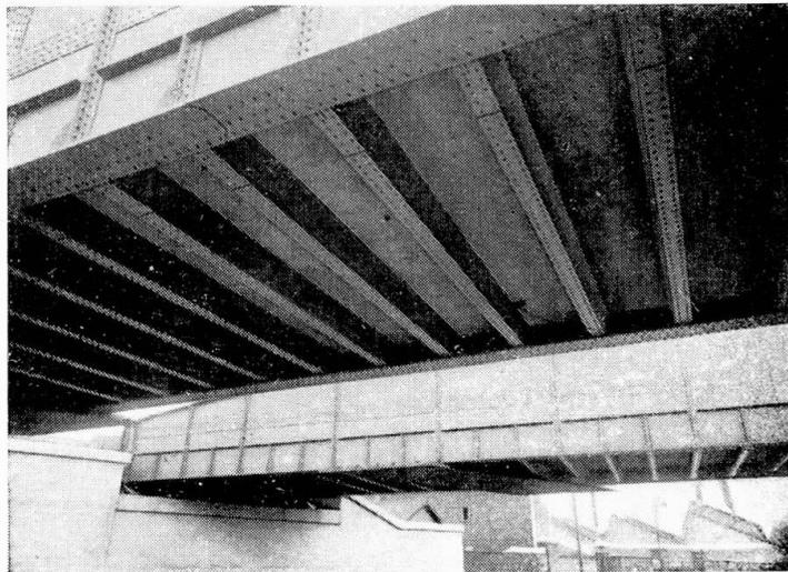
maintenue pendant toute la durée des travaux, grâce à l'emploi de ponts auxiliaires spécialement étudiés pour des travaux de ce genre.
