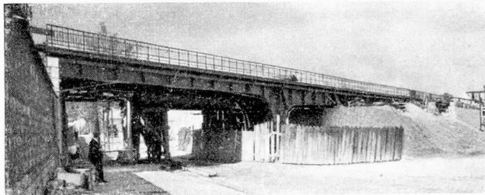
une vue par-dessous de cet ouvrage, qui se compose de deux ponts à une voie de 24 m d'ouverture. Chaque tablier est constitué par deux poutres latérales de hauteur variable à âme pleine, reliées par des pièces de pont métalliques enrobées, formant nervures d'un hourdis en béton armé de 0 m 20 d'épaisseur.
