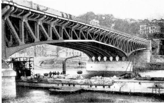
travées extrêmes est ainsi de 7 m 70. Malgré cela, en raison de la disproportion entre les travées imposée par la largeur de la chaussée et des trottoirs, on a dû alléger l'enrobage de la travée centrale par des évidements entre poutrelles et alourdir les travées extrêmes par des contrepoids en béton armé. L'ouvrage, qui a remplacé un ancien passage inférieur de 4 m, a été construit sous deux voies très fréquentées, sur lesquelles la circulation a été
