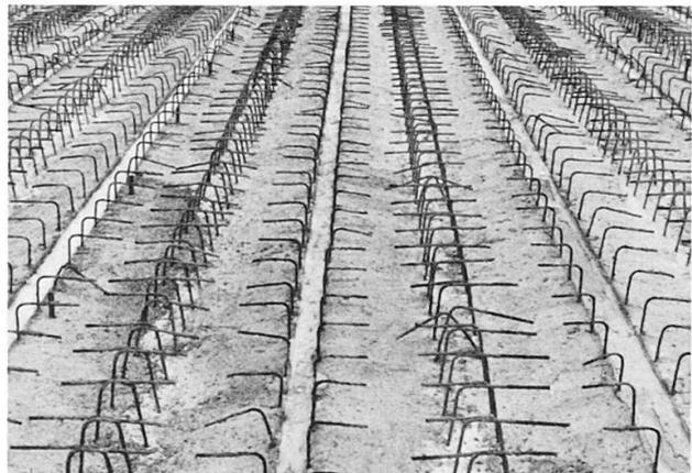
Bild 6: Fotografie der Verbundbügel zwischen Ortbeton und Fertigteilen
