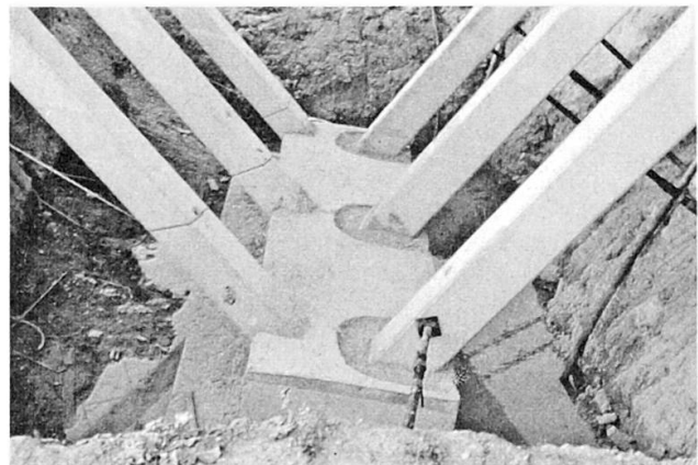
Fig. 6 Fundament mit V-Stielen
