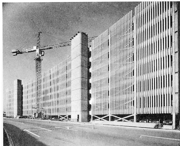
Parkhaus Fracht – Fertigzustand
