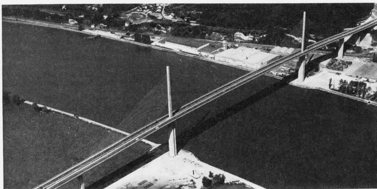
Fig. 6 - Vue de l'ouvrage terminé
