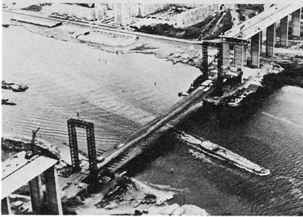
Levage de l'ensemble du tablier
