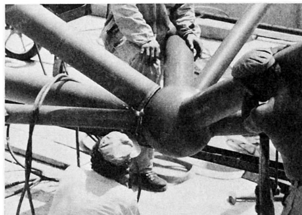
Fig. 4 Sphère de liaison entre béquille et traverse
