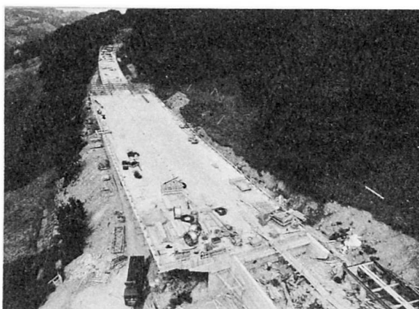
Vue de l'ouvrage depuis dessous avec le chariot de bétonnage des encorbellements latéraux.
