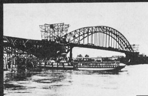
Die Stützbrücke bei Bonn ist in den Jahren 1896 - 1898 als Dreifachbogenbrücke mit aufgesetzter Fahrbahn erbaut worden. Leitung: Prof. Franz Otto Dietzmann, Baum Technik, Berlin.
