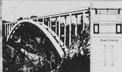
1928/29 Ammerbrücke bei Echelsbach Zweigelenkbogen in Melan-Bauweise mit aufgeständerter Fahrbahn, 130m Spannweite
