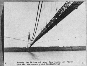
Ansicht der Brücke mit einer Spannweite von 720 m (vor der Verankerung des Windsystems)
