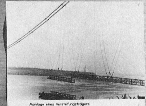
Montage eines Verstärkungsträgers
