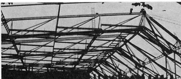
Bild 4 Haupttragkonstruktion – Bauzustand (Foto: Ch. Andoh)
