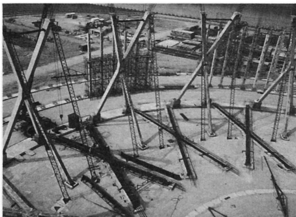
Poteaux X. Coffrage, mise en place. Poteaux de dispersion
