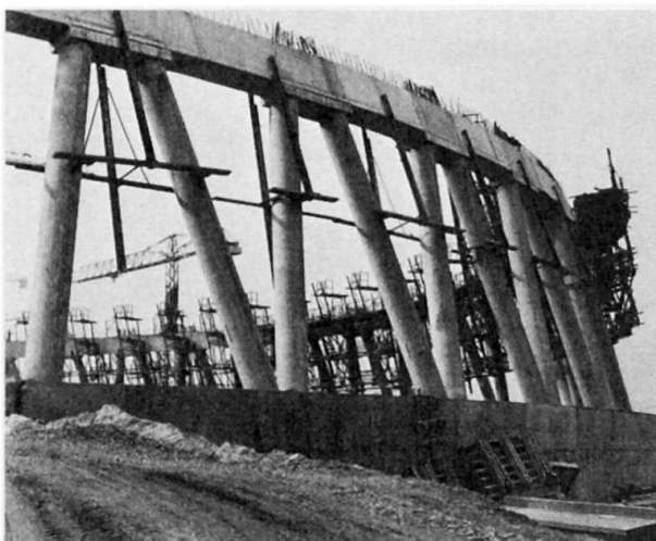
Poutre-linteau périphérique terminée. Montage de l'échafaudage du coffrage autogrimpant
