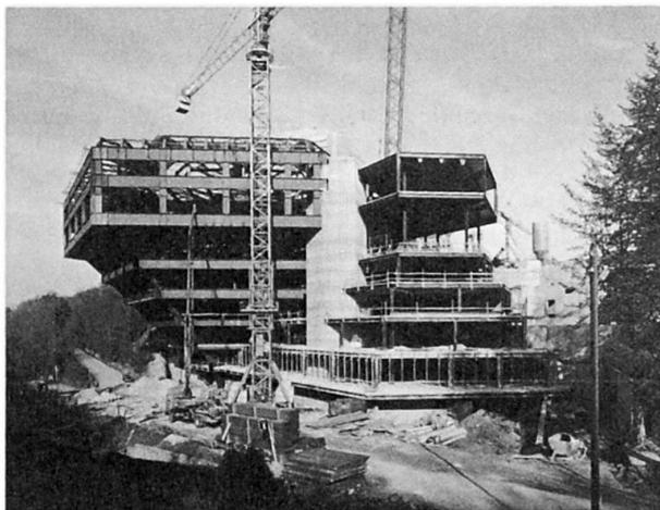
Fig. 3 Charpente métallique en fin de montage (mi-mai 1979)
