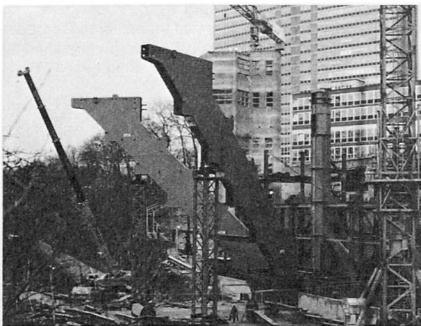
Fig. 2 Montage début mars 1979 des deux colonnes-caisson (29,8x3,5x0,9 m) dans l'encorbellement central
