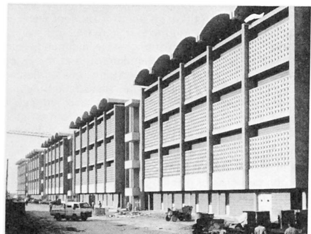
Bild 3 Fassade mit Schattengittern
