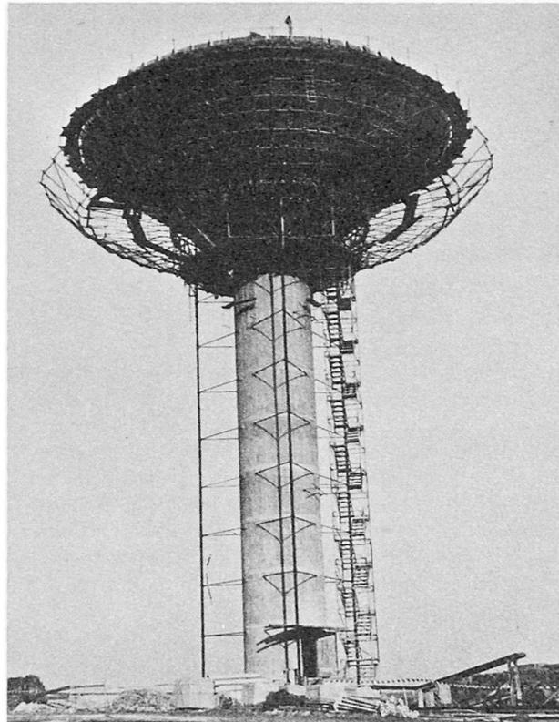
**Bild 3** Fertiggeschalter Wasserturm, bereits am
