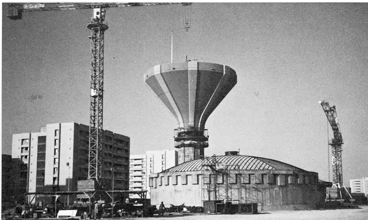
Vue d'ensemble en début de levage
