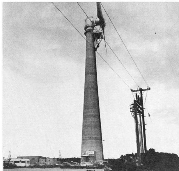
Bild 4 Die Turbinenachse liegt 80 m über dem Boden
