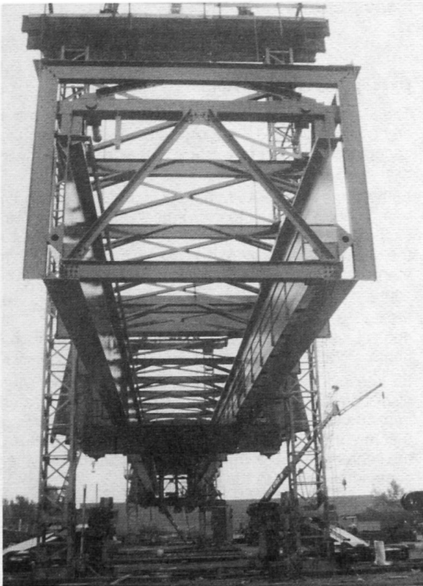
Bild 2 Stahlkonzeption für den Hauptträger
