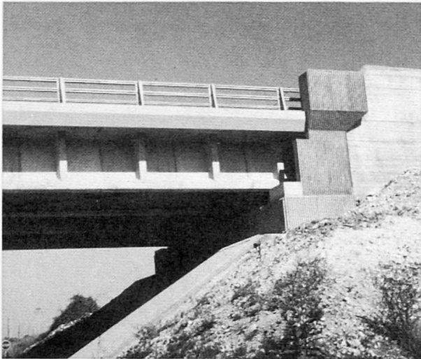
Fig. 3 Vue d'une extrémité de l'ouvrage
