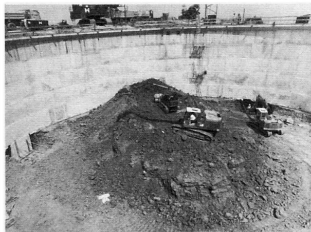
Bild 2: Aushub- und Betonierarbeiten in etwa 12 m Tiefe
