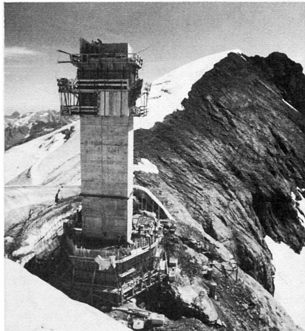
Bild 4: Rohbau August 1982: Liftturm mit Kletterschalung
