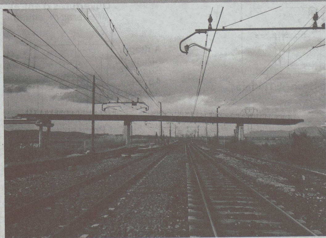
Cavalcavia ferroviario - n. 3 luci da 50 mt. - peso ton. 250
